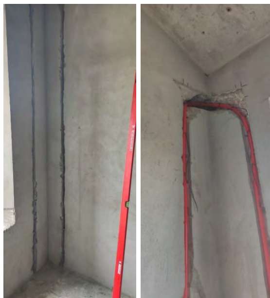
Рисунок 2 – Штроба под кабель в жилой комнате и непосредственно устройство кабеля в ней
